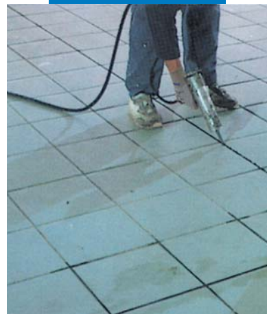
Zaptivanje keramičkog poda Mapesil-om AC
