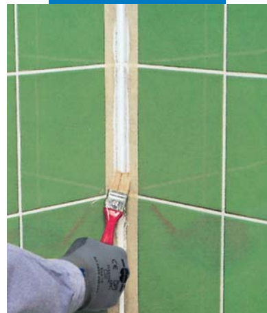
Zaglađivanje fuge sapunicom i četkom
