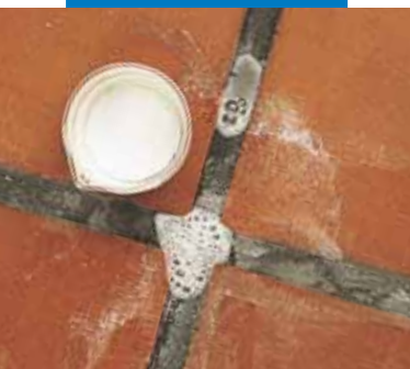
čišćenje mrlja od iscvetavanja
